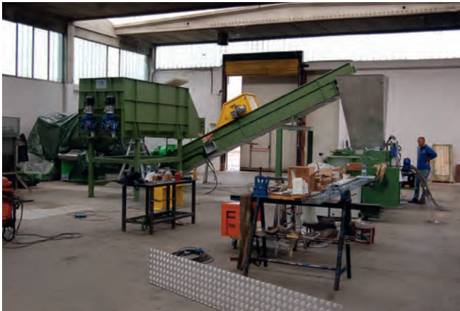
Machine- en installatiebouw bij Italrec
